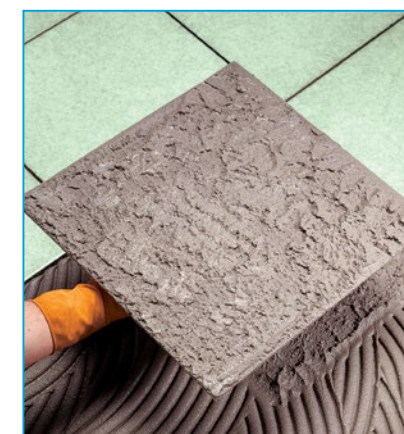
Burkolás kétoldalas kenéssel
