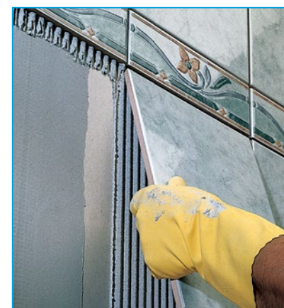
Burkolás egyoldalas kenéssel
